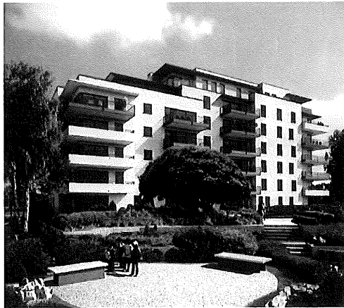
Bâtiment A : Façade arrière
