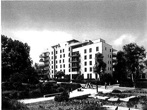
Bâtiment A : Façade avant
