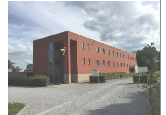
FOTO 4: zicht op gebouw van VZW sporen gelegen naast het perceel
